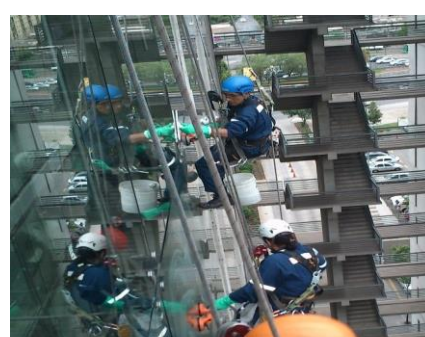
Limpieza de celosías de fachadas de edificios.
